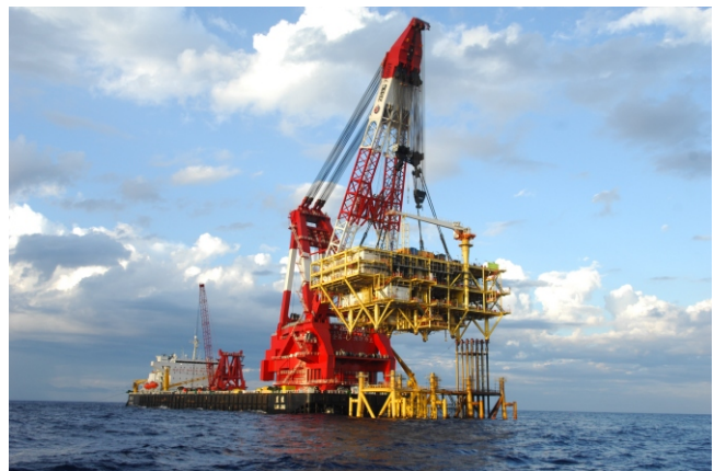
全球单臂最大起吊最重的7500吨蓝鲸号浮吊
